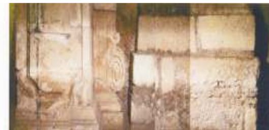
Lato destro facciata
