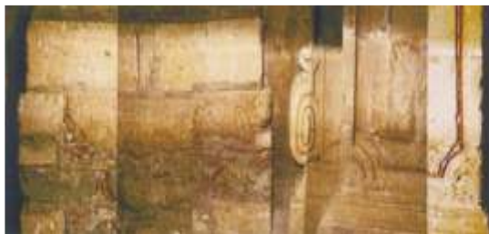
Lato sinistro facciata
